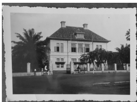
Afbeelding 4. Gebouw Kramat, reproductie van foto's van een nog onbekende fotograaf die zijn aangetroffen bij de Vincentius vereniging in Jakarta, januari 2020. De foto's komen uit 1938-1940.
