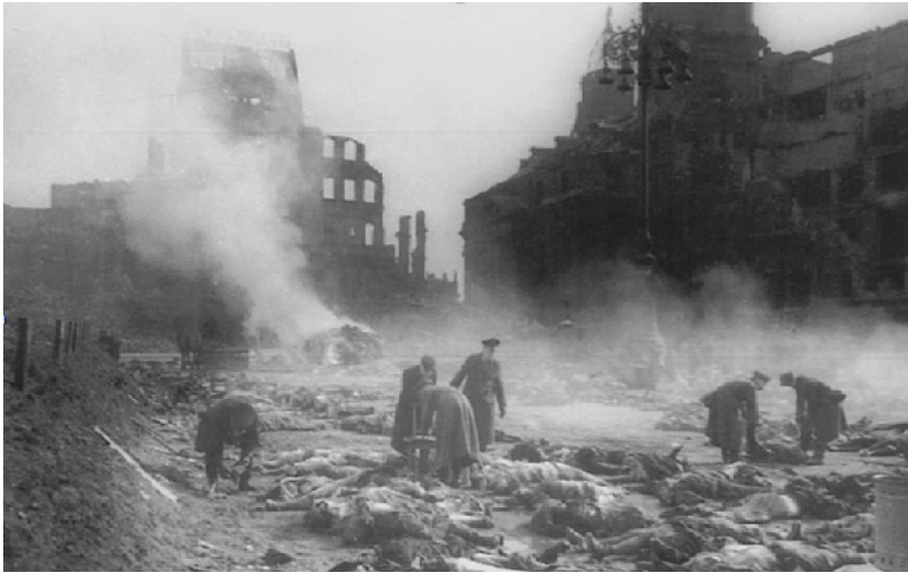
Dresden 1945. Afbeelding uit Brandstätten (2003).
